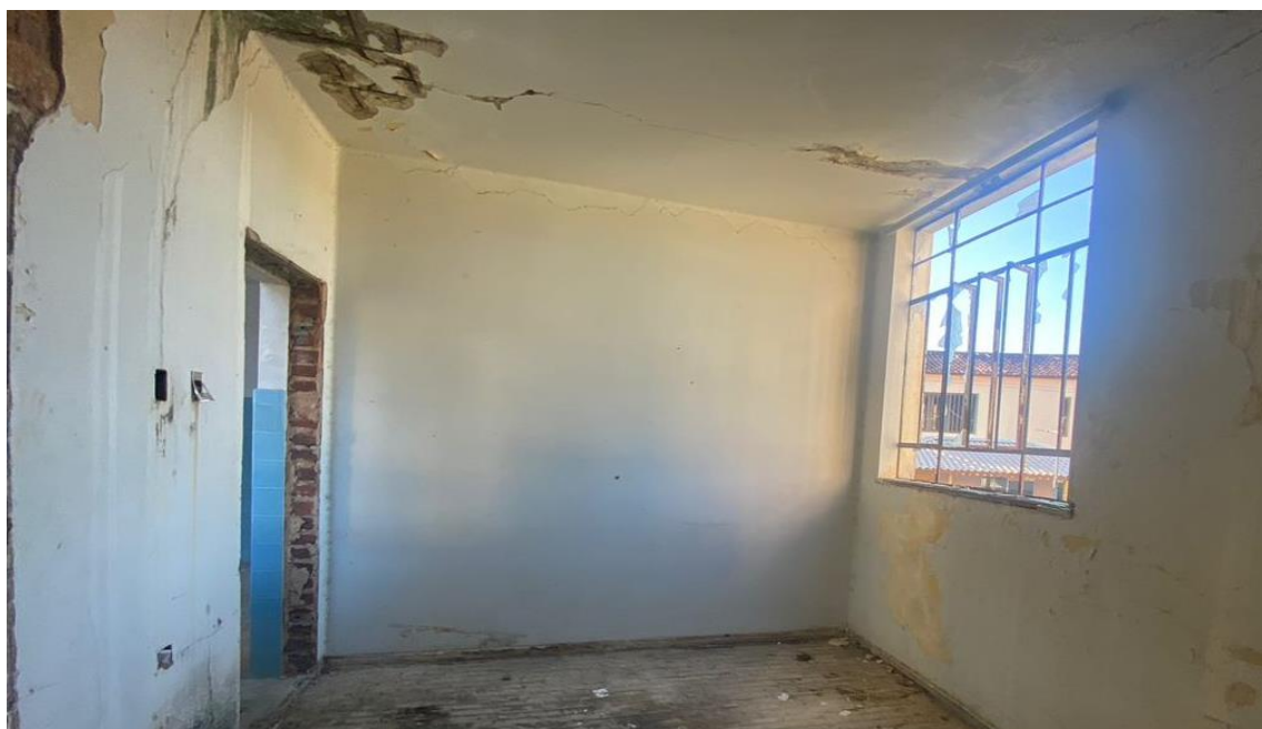
Figura 05. Imagem de uma sala do prédio da Coordenadoria Municipal de Educação, Itambé-BA.
