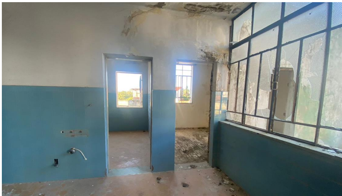
Figura 07. Imagem de uma sala do prédio da Coordenadoria Municipal de Educação, Itambé-BA.
